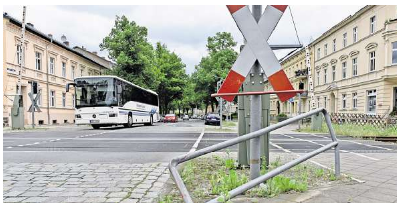
Schon vor Monaten wurde das Gitter am Bahnhof Rheinsberger Tor umgefahren – jetzt lässt die Bahn es reparieren
